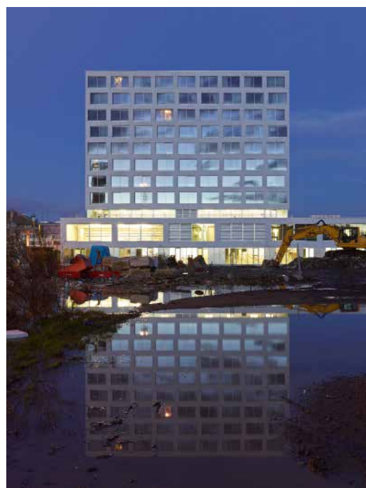
En haut : immeuble « Manny » à Nantes, chantier, Tetrarc architectes, 2009.
